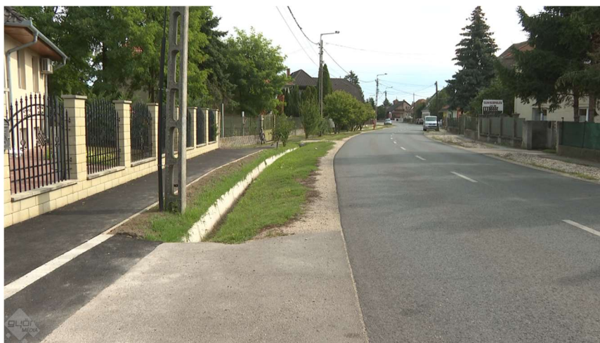
20. ábra: Felújított járdaszakasz Bácsa városrészben. Fotó: Ficsór Dávid, Győrplusz
